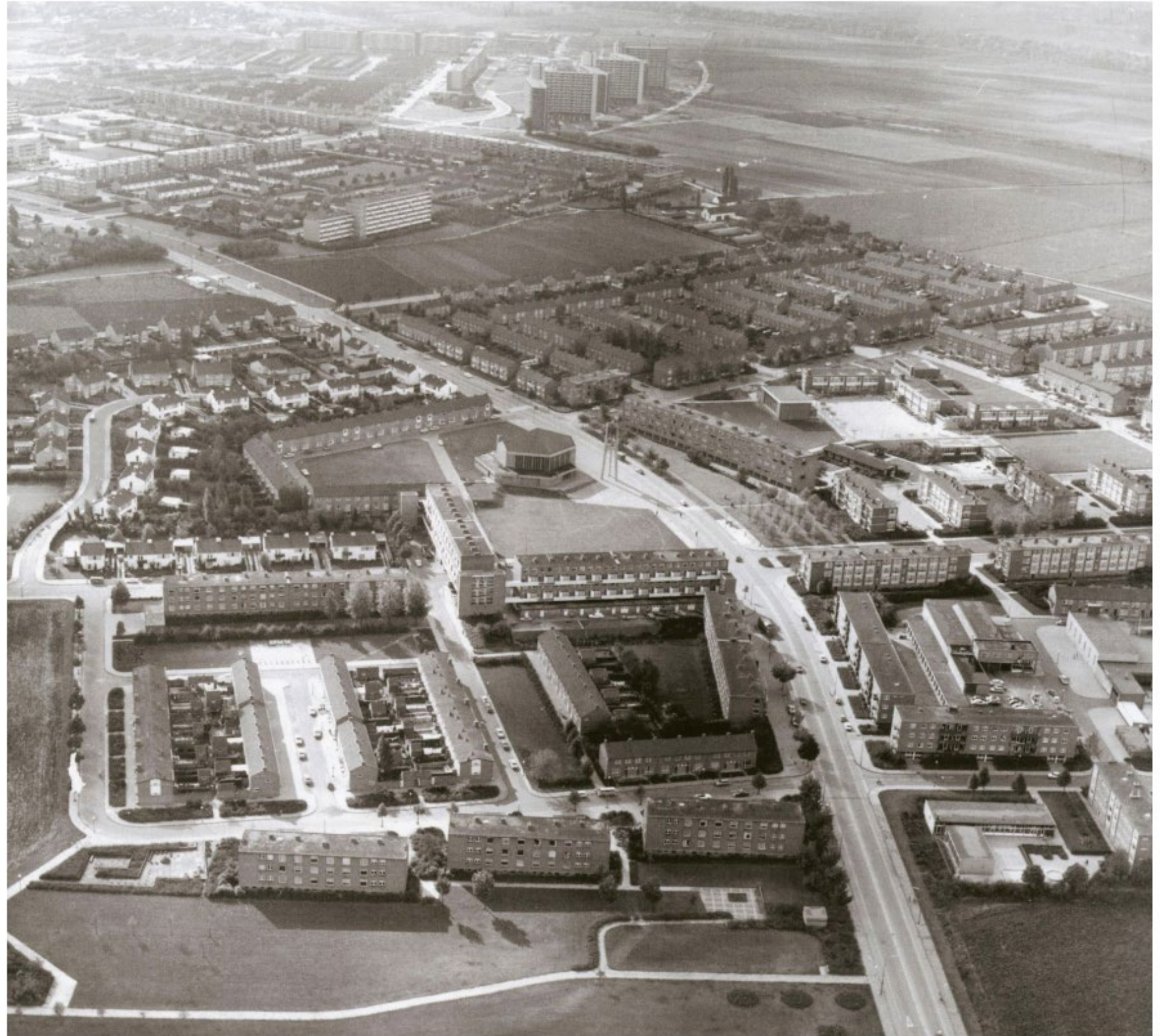
Luchtfoto Pottenberg na oplevering vanuit noorden, met midden door de wijk de Potteriestraat en daaraan het plein met de kerk. Bron: Regionaal Historisch Centrum Limburg.
