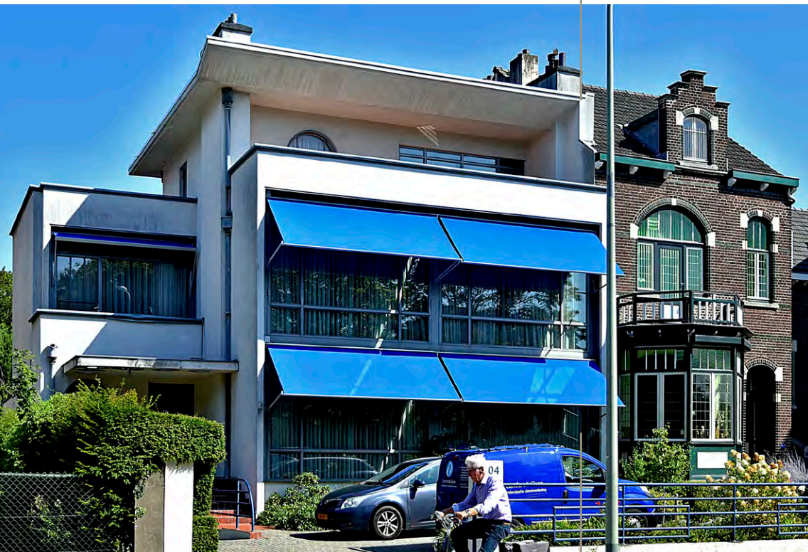
SCHARNERWEG 104, MAASTRICHT ■ BOUWJAAR 1933 ARCHITECT FRITS PEUTZ HEERLEN
