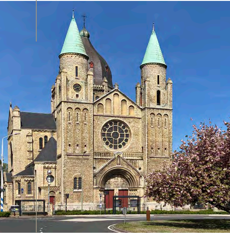
KONINGIN EMMALEIN, MAASTRICHT ■ BOUWJAAR 1916 ARCHITECT J.H.H. VAN GROENENDAEL, VERBOUWING 2016 ARCHITECT MATHIEU BRULS
