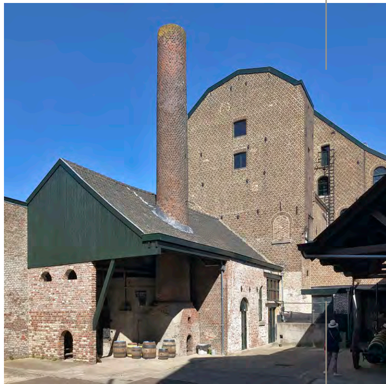
WYCKER GRACHTSTRAAT 26, MAASTRICHT ■ BOUWJAAR CA 1870-1884 ARCHITECT ONBEKEND
