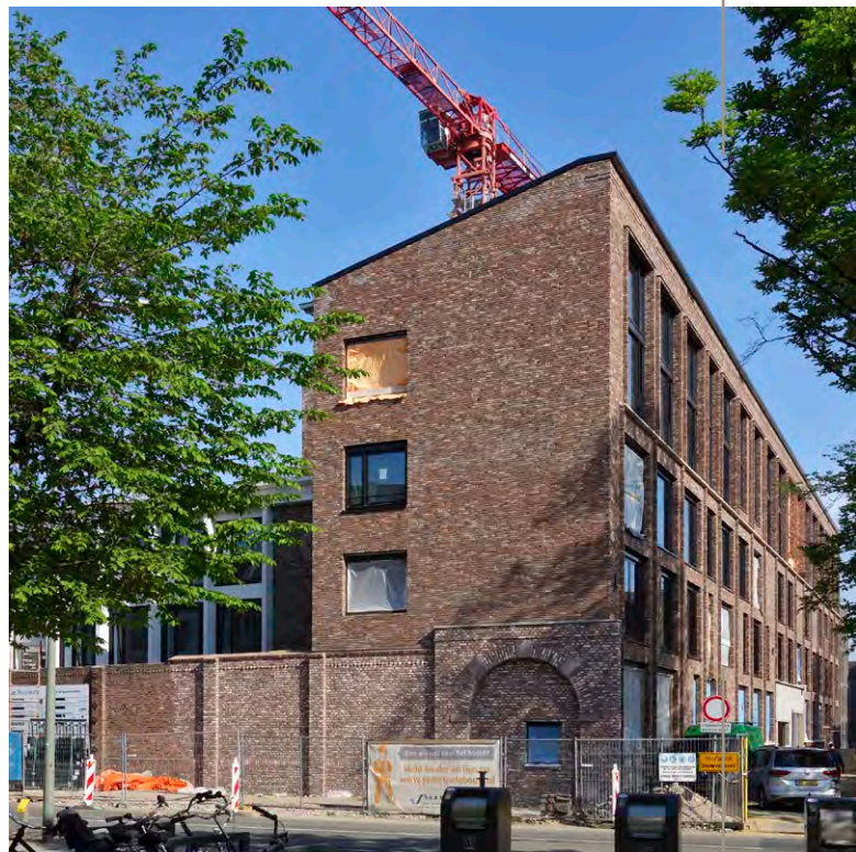
ANDRIESPOORT 16, SPHINXKWARTIER, MAASTRICHT BOUWJAAR 2018-2020 ■ ARCHITECT HUMBLÉ-MARTENS-WILLEMS
