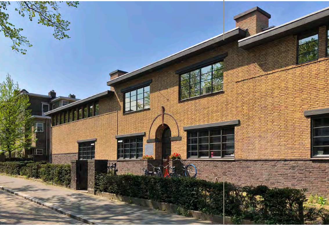
STATENSINGEL 138, MAASTRICHT ■ BOUWJAAR 1929 ARCHITECT J.W. SANDHÖVEL
