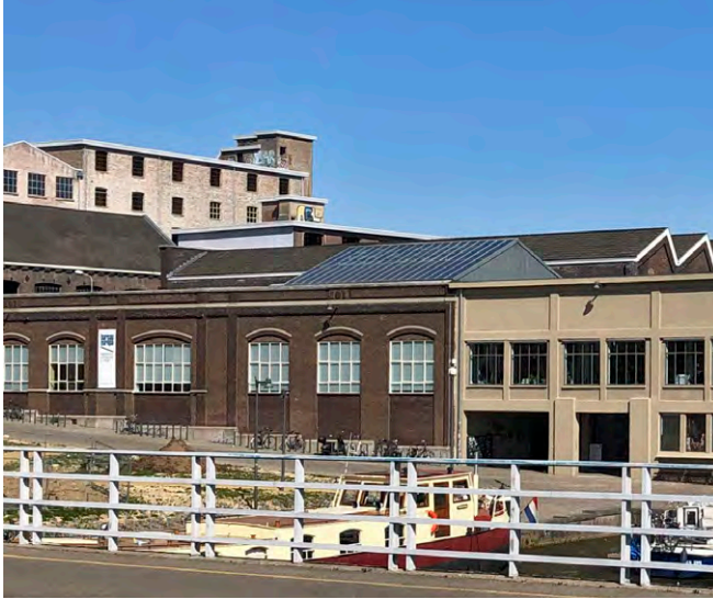
BOSCHSTRAAT 5, MAASTRICHT ■ BOUWJAAR 1906 ARCHITECT ONBEKEND
