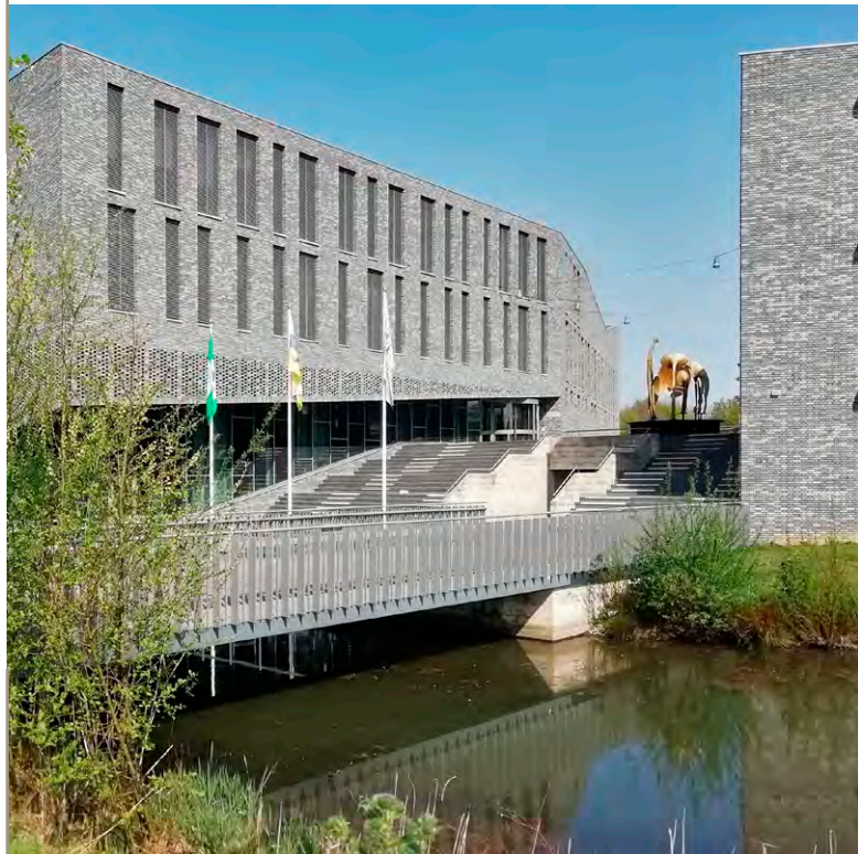
DISCUSWORP 55, MAASTRICHT ■ BOUWJAAR 2013 ARCHITECT FRENCKEN-SCHOLL-ARCHITECTEN
