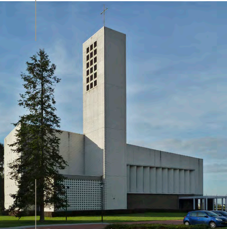
O.L. VROUWEPLEIN 4, EIJSDEN ■ BOUWJAAR 1959 ARCHITECT EUGÈNE HOEN
