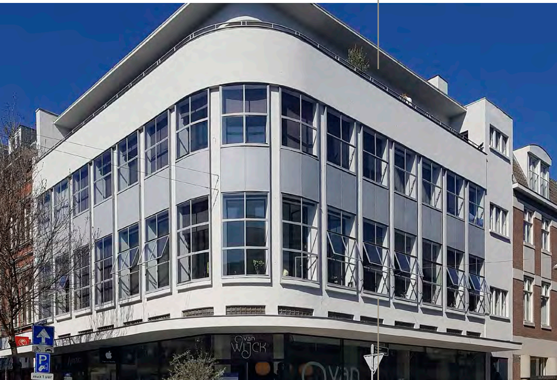
WYCKER BRUGSTRAAT 26, MAASTRICHT ■ BOUWJAAR 1932 ARCHITECT J. JOOSTEN
