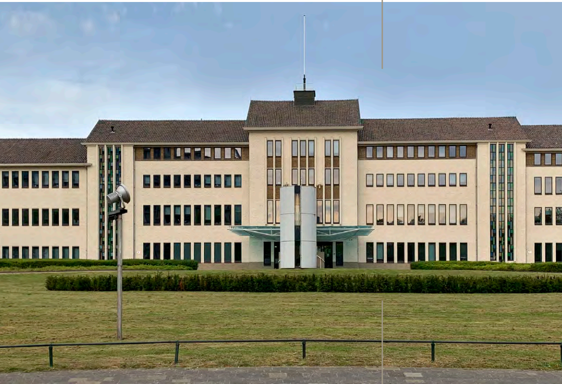
SINT ANNADAL 1, MAASTRICHT ■ BOUWJAAR 1950, VERBOUWD 1992 ARCHITECT CUYPERS-SWINKELS, VERBOUWING ARCHITECT SWINKELS-PASSCHIER
