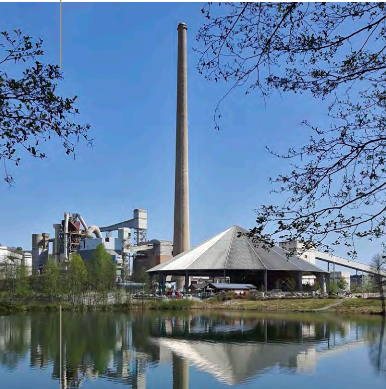
LAGE KANAALDIJK 115, MAASTRICHT ■ BOUWJAAR 1968 ARCHITECT ONBEKEND
