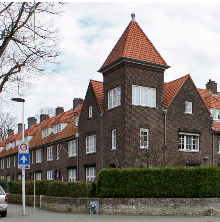
SCHARNERWEG, MEERSSENERWEG, PROF. P. WILLEMSSTRAAT, PROF. ROERSCHSTRAAT, MAASTRICHT BOUWJAAR 1921 ■ ARCHITECT MARRES EN SANDHÖVEL
