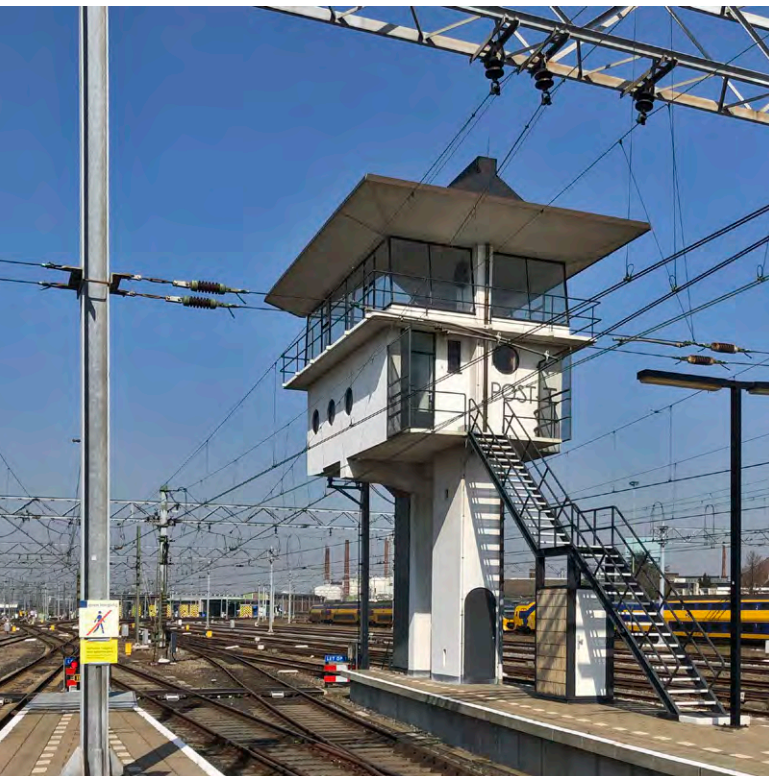
SEINHUIS AAN DE UITERSTE NOORDZIJD VAN PERRON 3/4 STATION MAASTRICHT ■ BOUWJAAR 1933 ■ ARCHITECT SYBOLD VAN RAVESTEYN
