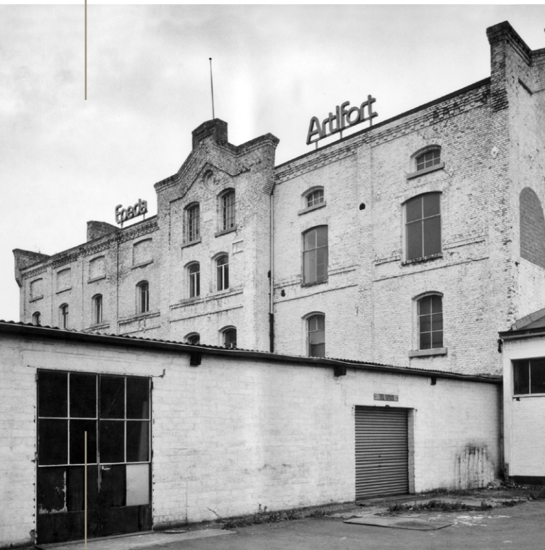
SINT ANNALAAAN, MAASTRICHT ■ BOUWJAAR 1884-1887, GESLOOPT 1985 ARCHITECT: ONBEKEND
