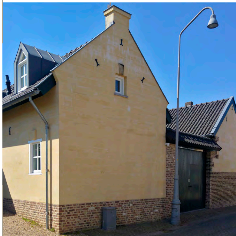
PLETZERSSTRAAT 48, MAASTRICHT ■ BOUWJAAR 2008-2011 ARCHITECTEN N-ARCHITECTEN B.V. MAASTRICHT, PETER CLAASSEN. AFBOUW BINNEN EN ONTWERP TUIN AMA GROUP ASSOCIATED ARCHITECTS MAASTRICHT, ARNO MEIJS
