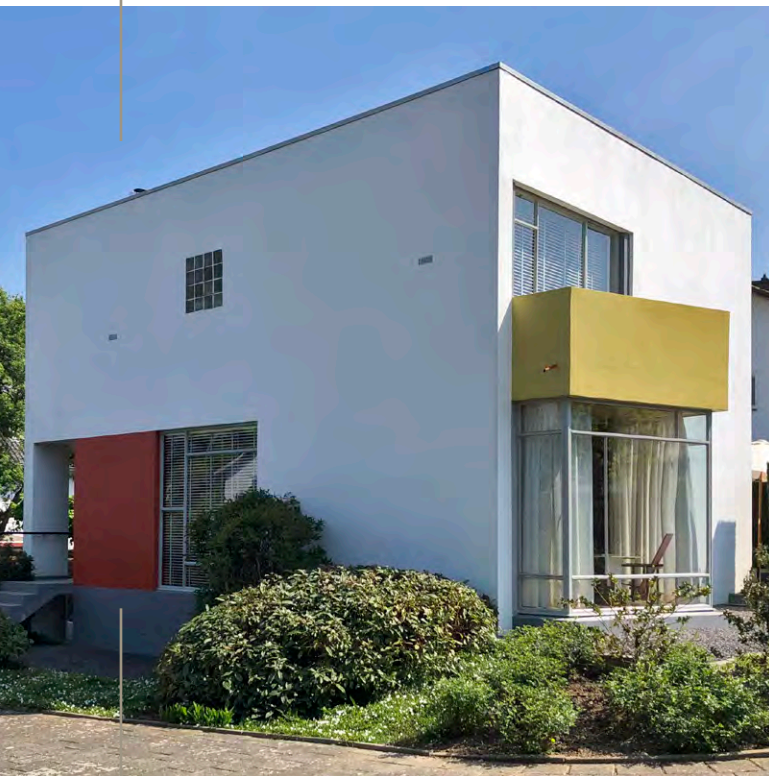
SINT ROCHUSWEG 5, MAASTRICHT ■ BOUWJAAR 1955-1956 ARCHITECT SAN CLAESSENS
