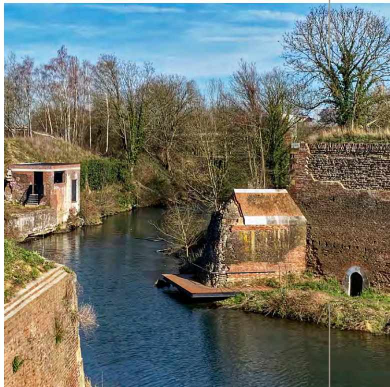
ACHTERZIJD E STATENSINGEL, MAASTRICHT BOUWJAAR 17 E , 18 E EN BEGIN 19 E EEUW ARCHITECT SÉBASTIEN LE PRESTRE DE VAUBAN
